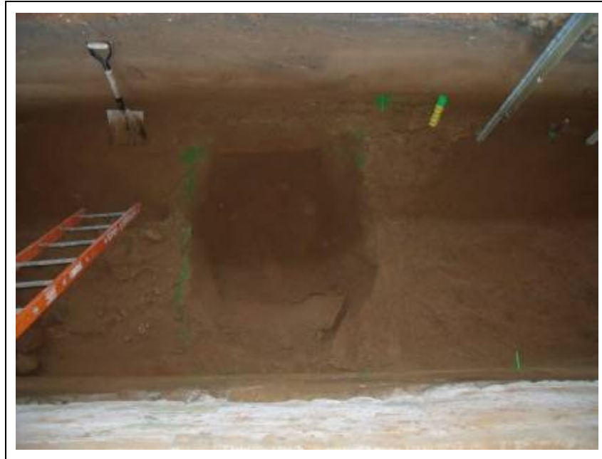
Foto.20 , Sector oest, vista zenital del segon pou de drenatge
