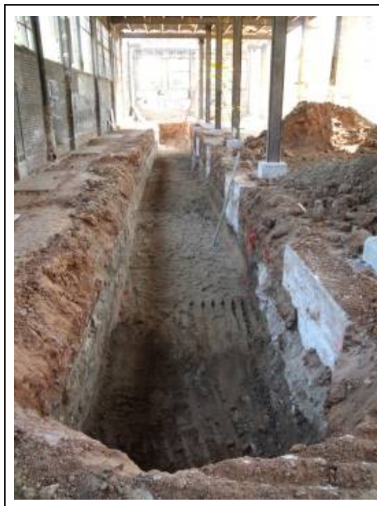
Foto.7 Sector est, foto final, des del nord.
