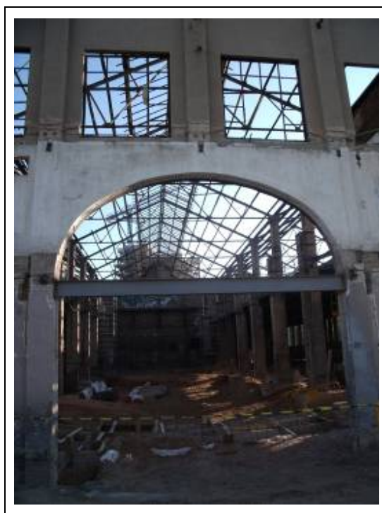
Foto.1 Nau central previ als treballs, des del sud.
