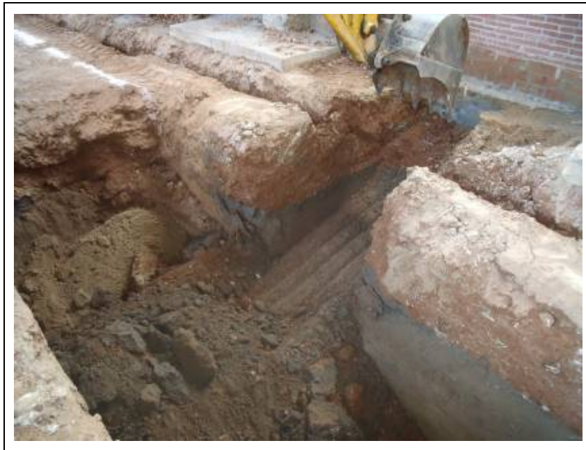
Foto.18, Sector oest, rebaixos de terres pel ramal, des del nord-est
