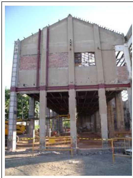
Foto.3 Nau oest previ als treballs, des del sud
