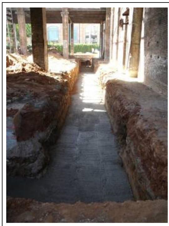
Foto.13 Sector nord, foto final amb part de la rasa construïda, des de l'est.
