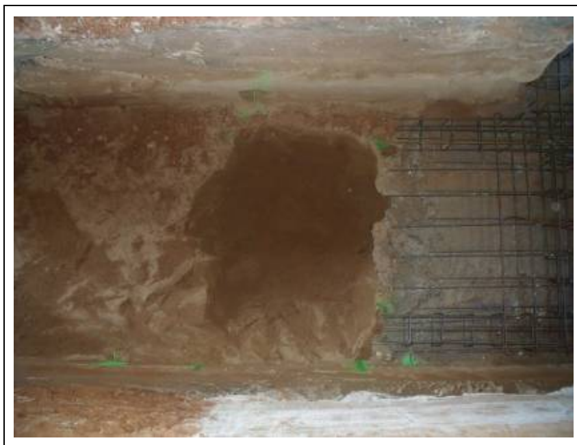
Foto.19, Sector oest, vista zenital del primer pou de drenatge
